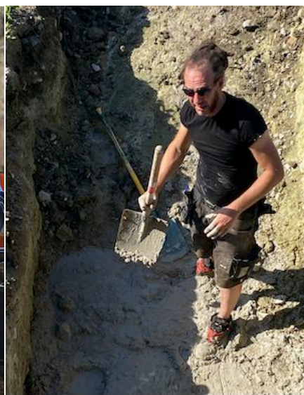
Extérieur : examen des murs du bassin
